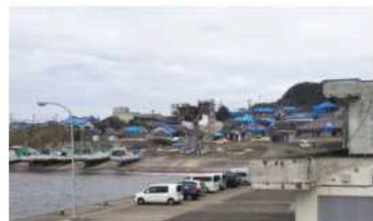
ブルーシートで屋根を保護する家屋(気象庁職員撮影)
