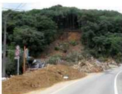
熊本県芦北町の土砂災害 (写真：気象庁職員撮影)
