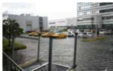
関西国際空港の浸水 (気象庁職員撮影)
